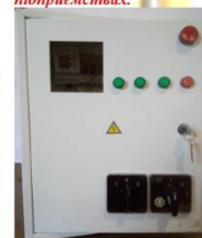
Рис. 2. Загальний вигляд щита керування електрокалориферної установки.
